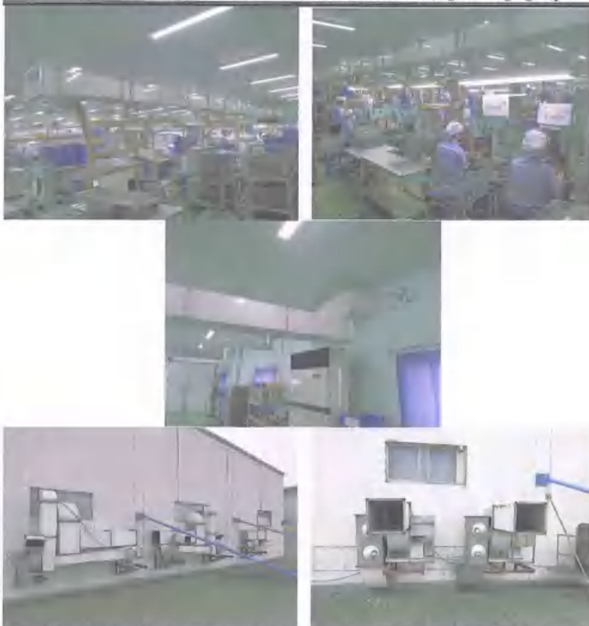
Hình 3. 12. Hệ thống thông gió và chụp hút tại khu vực xưởng in ấn, lắp ráp sản phẩm nhựa
