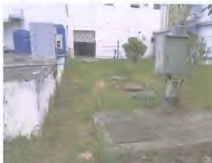
Hình 3. 7. Bể xử lý nước thải số 02
