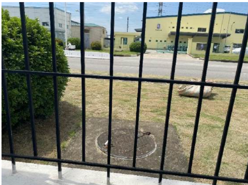
Hình 3. 5. Hình ảnh hố ga chung đầu nối với hệ thống thoát nước KCN
