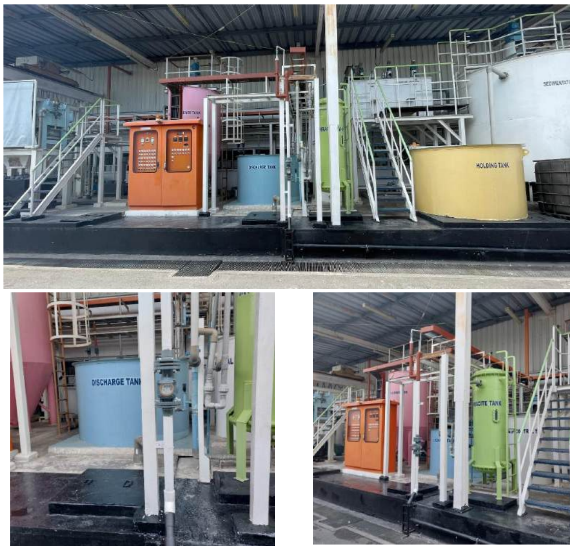
Hình 3. 13. Hệ thống xử lý nước thải sản xuất số 01 (xây dựng 2008)
