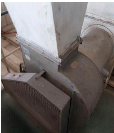
Hình 3. 26. Hình ảnh quạt hút gió khu vực tiền xử lý sơn
