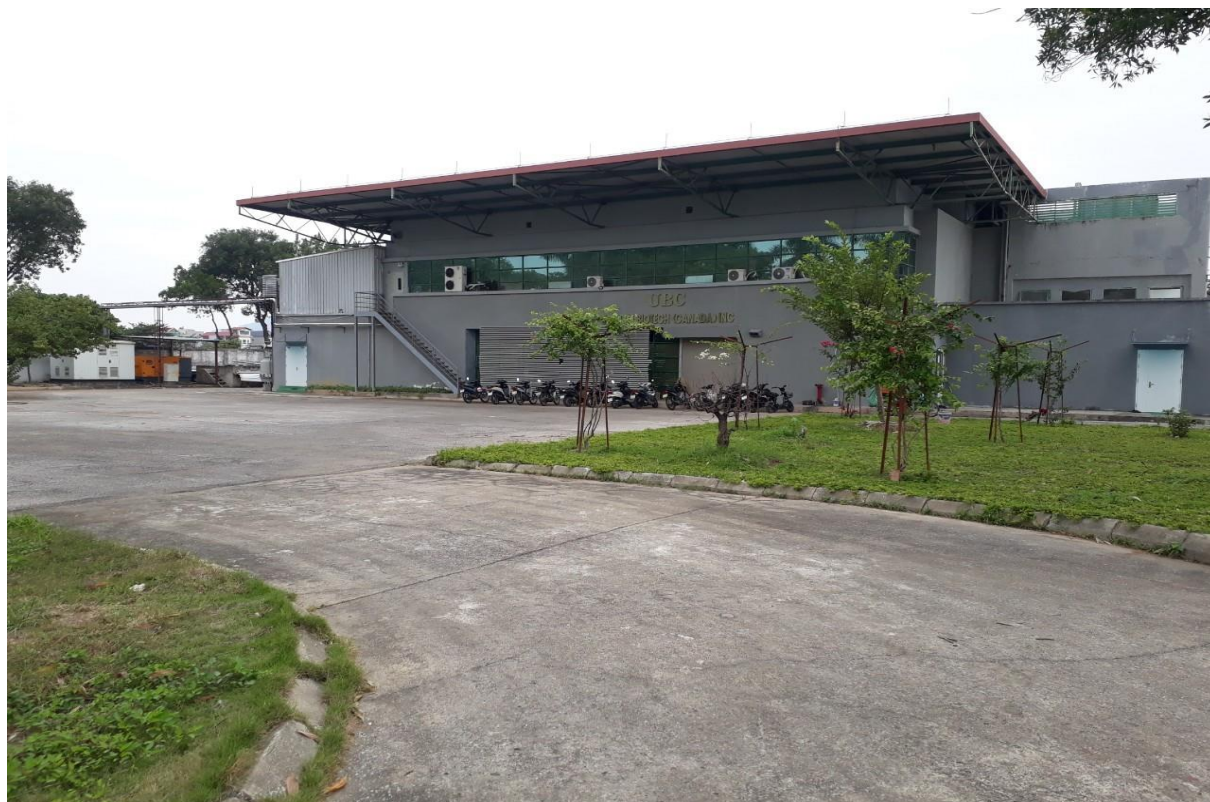
Hình 1.13. Hiện trạng khu vực nhà máy
