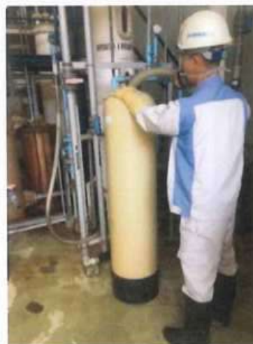
Hạt nhựa trao đổi ion của hệ thống xử lý nước sạch, nước siêu sạch đã được hoàn nguyên, đóng gói và giao trả Khách hàng
