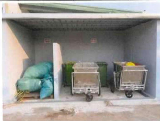
Hình ảnh: Kho chứa rác thải sinh hoạt
