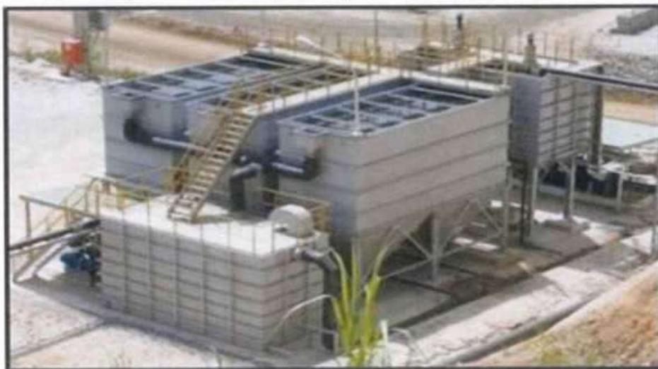
Hình 1.7. Lắp đặt hệ thống bể phản ứng và bể lắng cho hệ thống xử lý nước sạch tại công trường thi công – nhà máy của khách hàng
