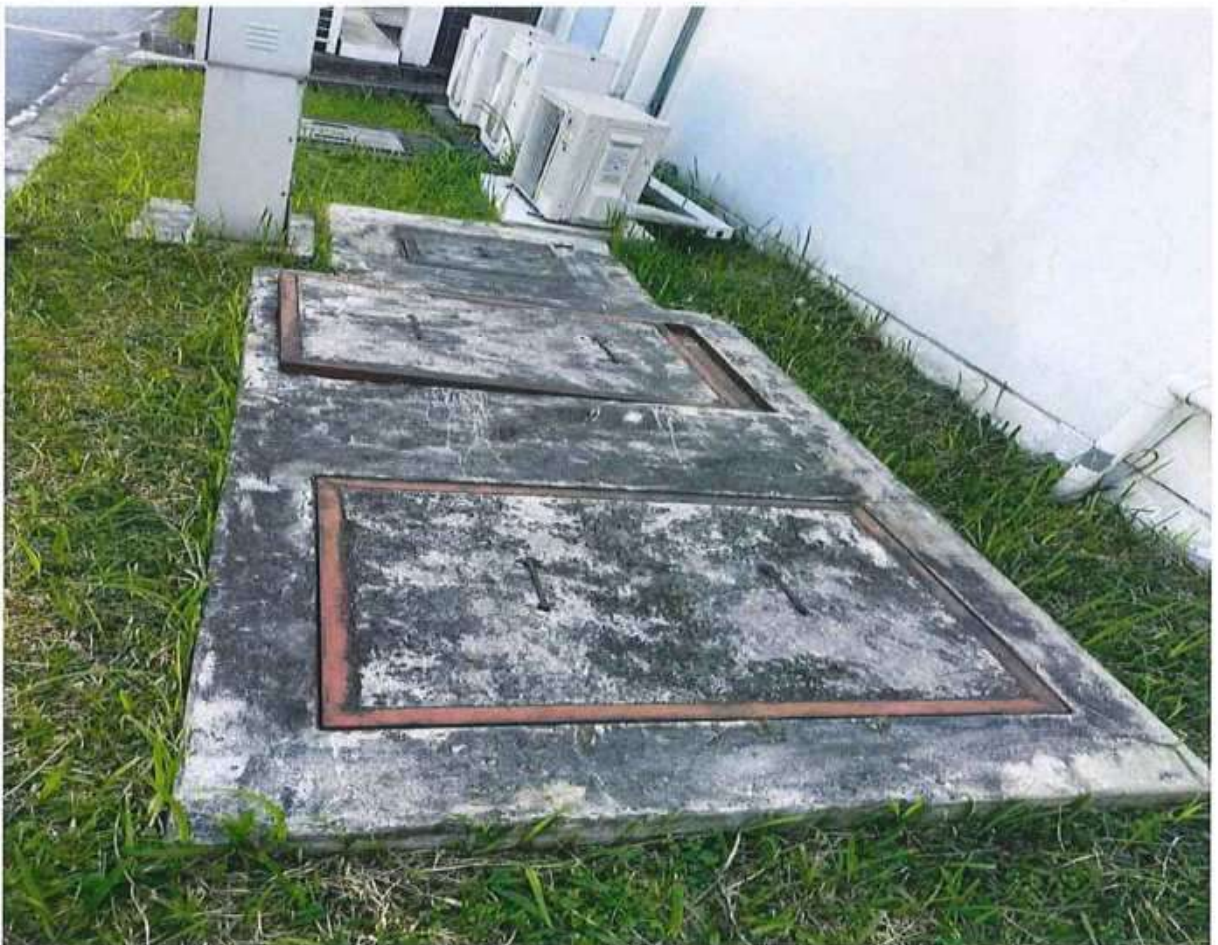
Hình 3.3. Hình ảnh bể chứa tại nhà máy
