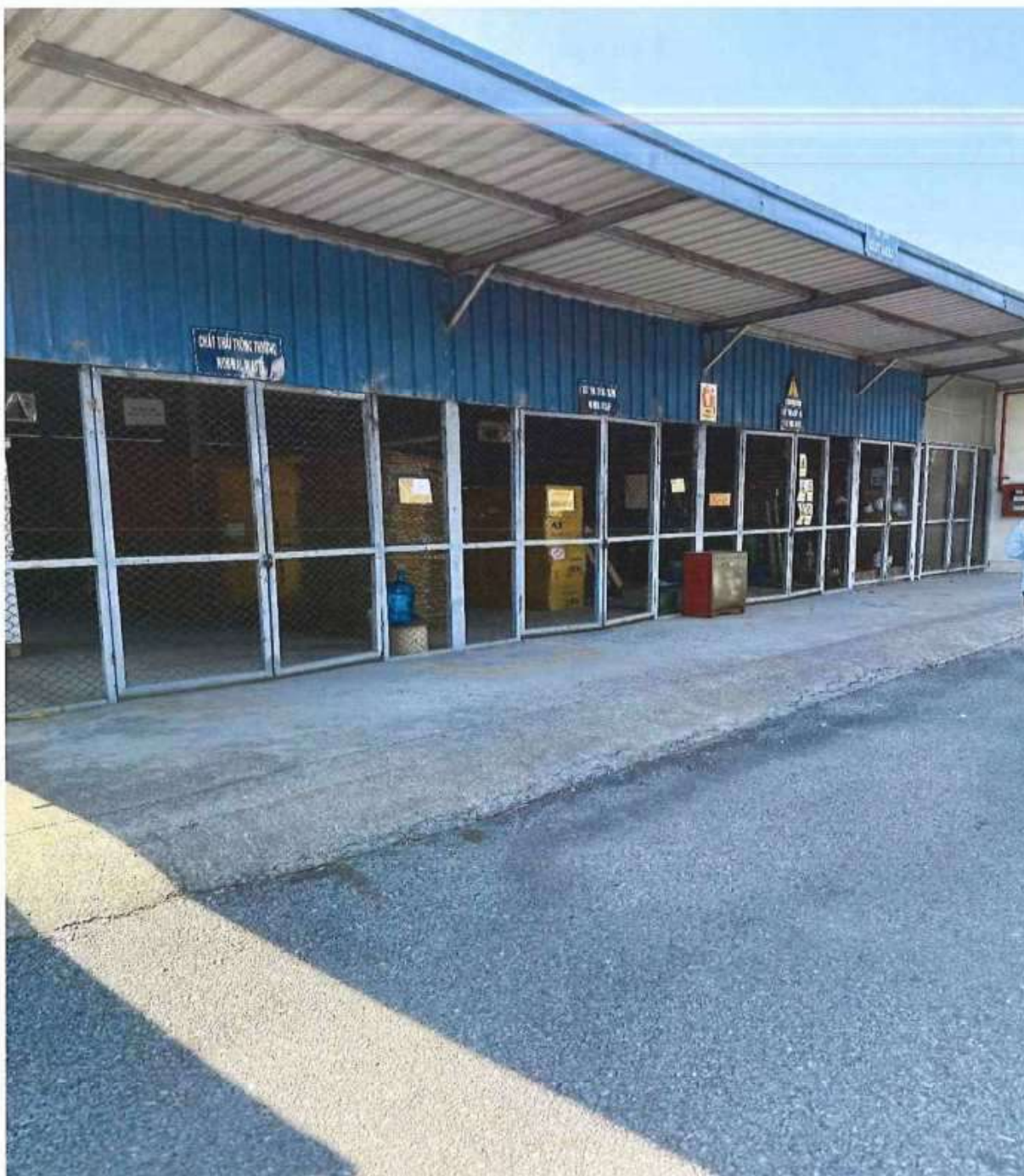
Hình 3.9. Hình ảnh kho rác thải tại nhà máy
