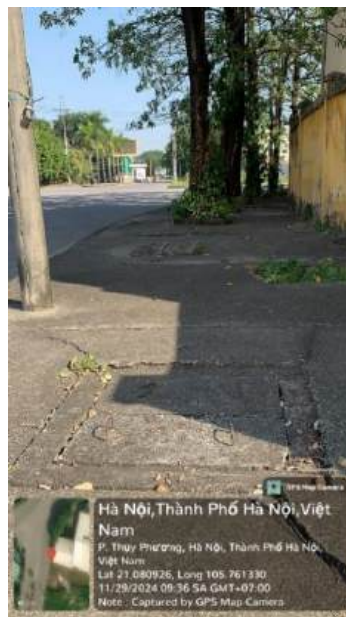
Hình 21. Điểm đầu nối nước thải vào hệ thống thoát nước của KCN (GT17)
