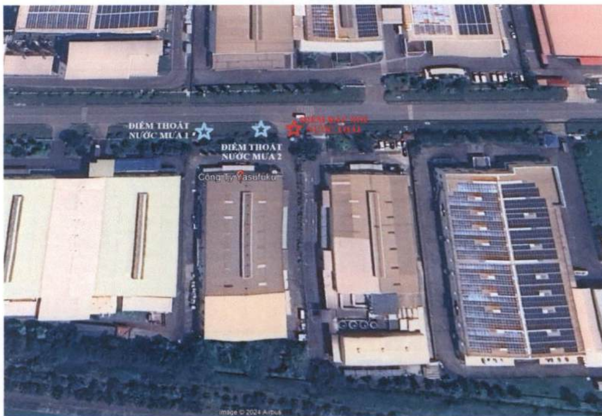
Hình 3-3: Điểm đầu nối nước mưa và nước thải của Cơ sở với hệ thống thoát nước mưa, thu gom nước thải KCN Thăng Long
