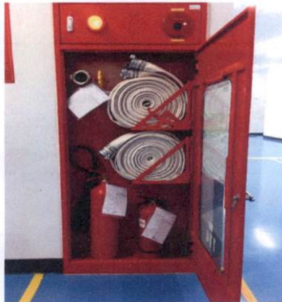
Hình 3-8: Trang thiết bị PCCC tại Nhà máy
