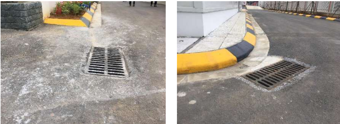
Hình 5: Hình ảnh hồ ga thu nước mưa
