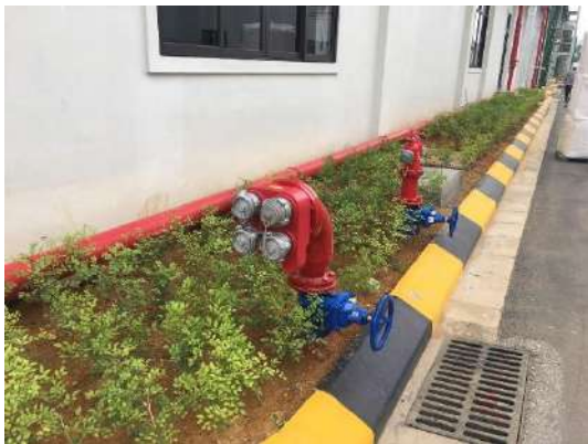
Hệ thống họng chữa cháy và bình cứu hỏa
