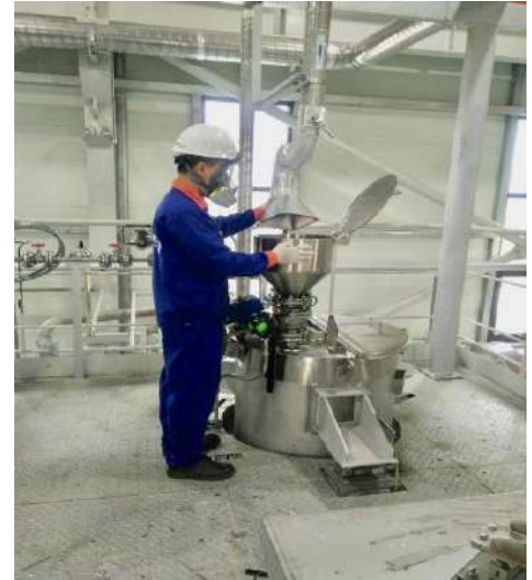
b) Chụp hút tại phễu nạp liệu H-703
