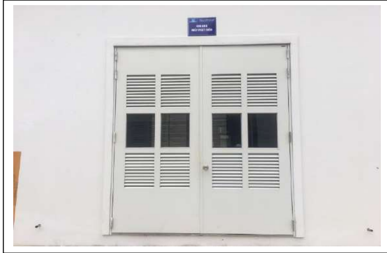
Hình 15: Vị trí khu nhà đặt máy phát điện
