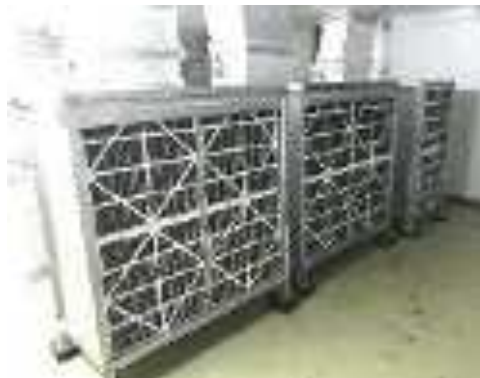
Hình 3.12. Hệ thống quạt hút khí thải sơn
