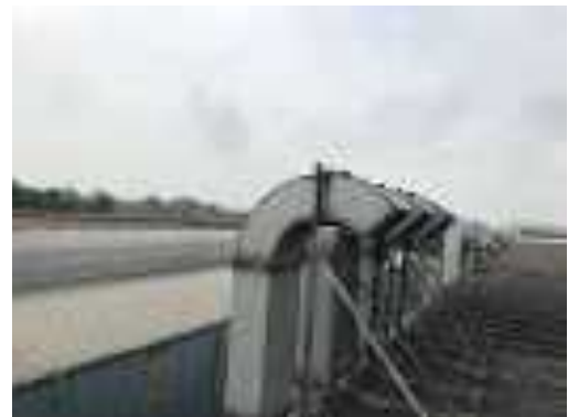
Hình 3.13. Ống khói dây chuyền sơn
