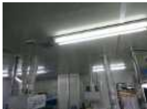
Hình 3.8. Chụp hút và đường dẫn khí dây chuyền in
