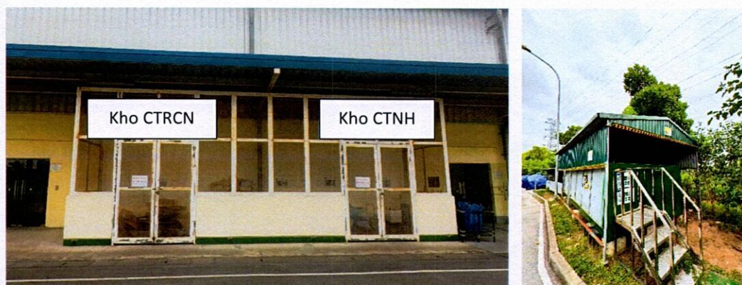
Hình 4-11. Kho chứa CTR công nghiệp thông thường (phế liệu) cạnh kho CTNH và hình ảnh container chứa CTCNTT của cơ sở
